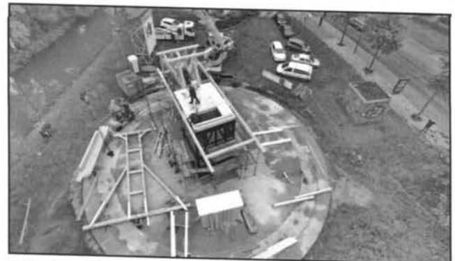
Abb. 10: Richten der Holzkonstruktion, 15. Oktober 2015. Kopter-Aufnahme Fa. LÜTCKEN, OHZ
