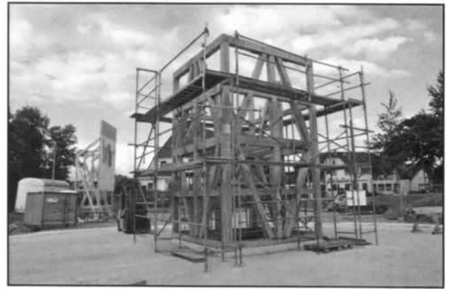
Abb. 8: Das unverklinkerte Turm-Fachwerk, 25. September 2015. Foto: K.-D. UHDEN
