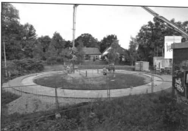
Abb. 7: Gießen der Sohlplatte am 30. Juli 2015. Foto: K.-D. UHDEN
