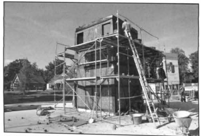
Abb. 9: Verklankern des Turms am 2. Oktober 2015. Foto: K.-D. UHDEN
