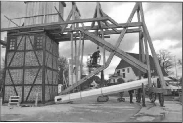
Abb. 14: Tubusmontage am 18. November 2015 (Spiegel zu diesem Zeitpunkt noch nicht eingebaut). Foto: K.-D. UHDEN
