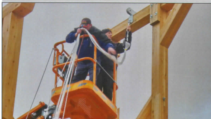
Abb. 9: Montage der Rollen.
